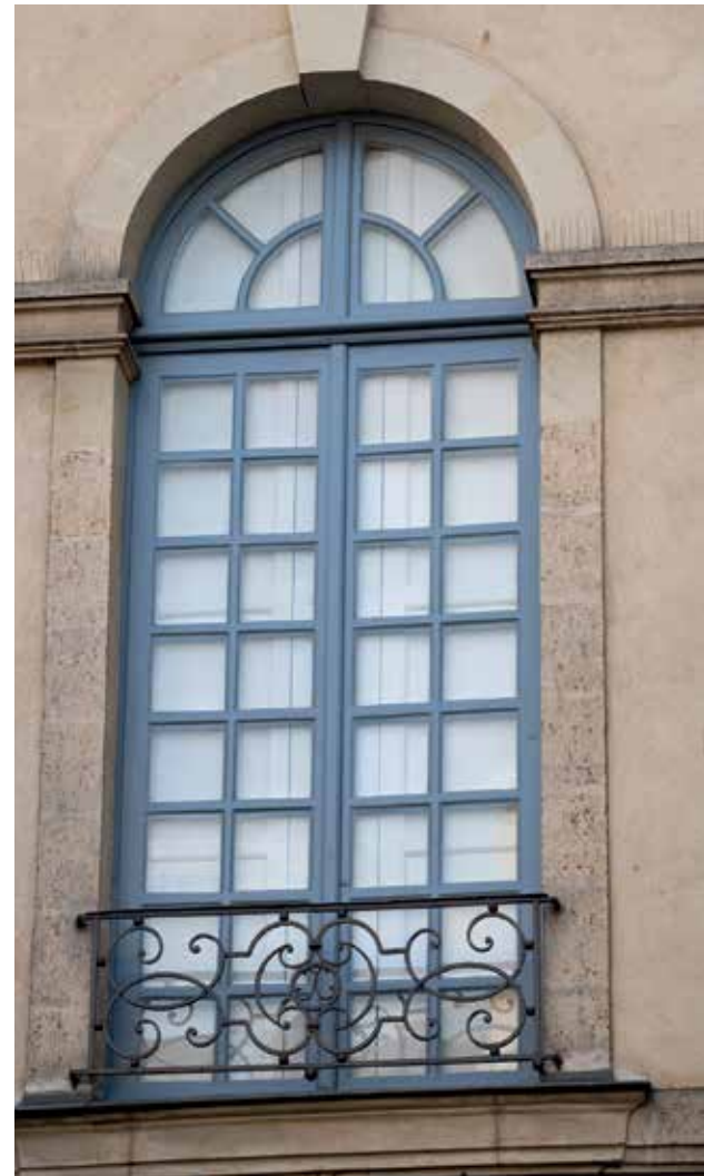
Fenêtre de l'hôtel Senant, rue de la Monnaie, avec le chiffre de cette famille en voie d'anoblissement sur les ferronneries du balcon.
