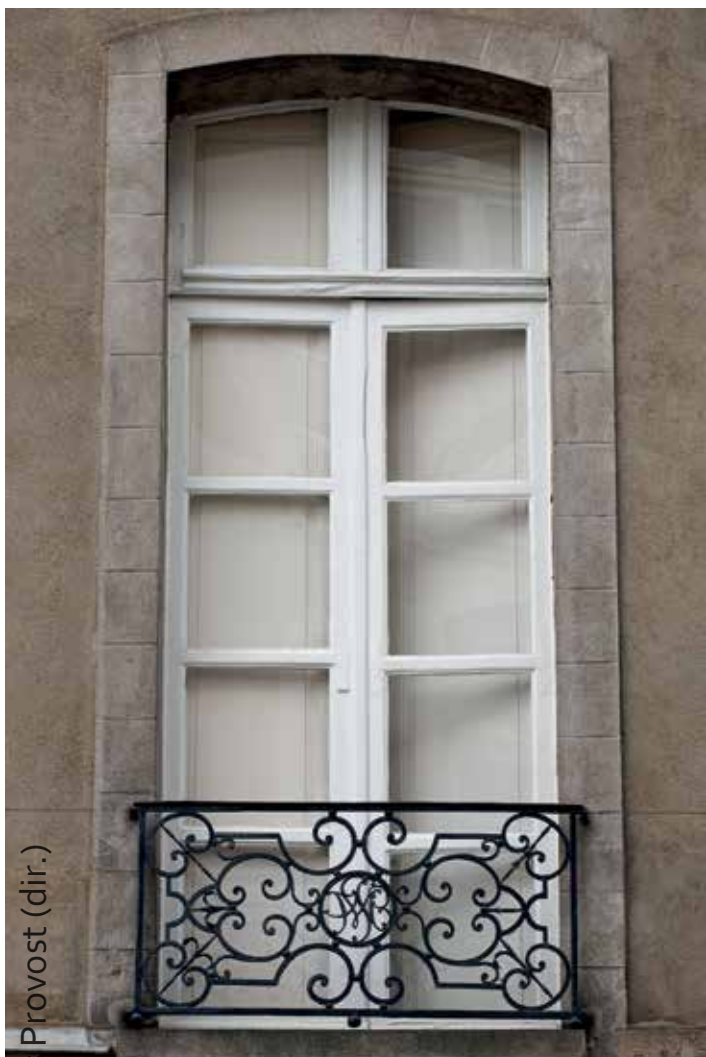
Fenêtre typique des immeubles de la reconstruction, rue d'Estrées, avec sur le balcon le chiffre du bâtisseur, Bernard de Kersavet, procureur au parlement.
