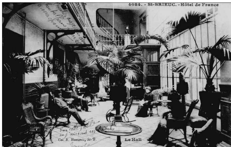
Fig. 10. Hôtel de France, Saint-Brieuc (Côtes-d'Armor). Le hall moderne mais spartiate d'une caserne hôtelière, (coll. F. Thomas).
