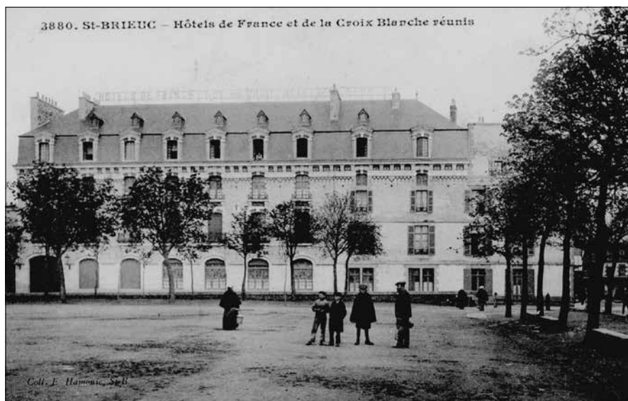
Fig. 9. Hôtel de France, Saint-Brieuc (Côtes-d'Armor), aujourd'hui transformé en bureaux et locaux commerciaux. La façade initiale a été conservée, à l'exception de l'aile droite (hôtel de la Croix blanche) devenue l'annexe d'un autre établissement, (coll. F. Thomas).
