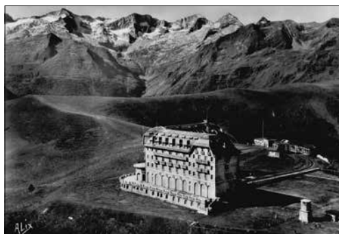
Fig. 6. Grand hôtel, Superbagnères (Haute-Garonne). Ce palace ouvert en 1922 par la Compagnie des chemins de fer du Midi, puis entré dans une longue agonie, est repris avec l'aide des collectivités par les Villages clubs du Soleil qui exploitent ses 140 chambres à deux étoiles depuis 2007, sur deux saisons. Preuve que la localisation ne fait pas tout, (coll. P. Harismendy).
